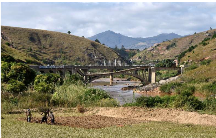
Photo : le pont détruit et juste derrière le remplaçant
